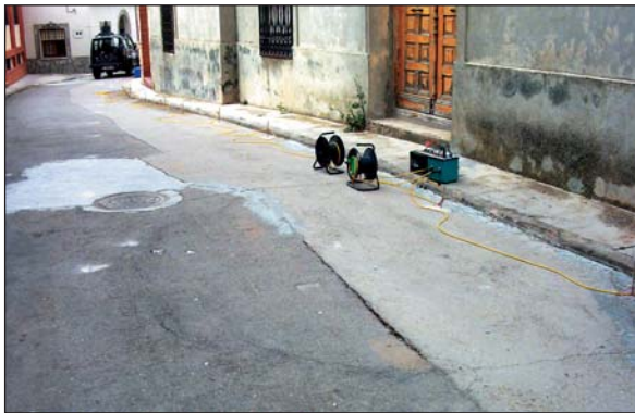
Arriba. auscultación de un socavamiento en el firme y su continuación lateral (Honrubia, Cuenca). Corresponde al perfil de la Figura 7.
