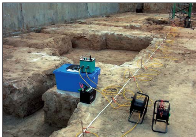
Colocación de una línea de electrodos: perfil geoelectrico en las inmediaciones de la excavación de una zapata de cimentación en Navalcarnero (Madrid).
